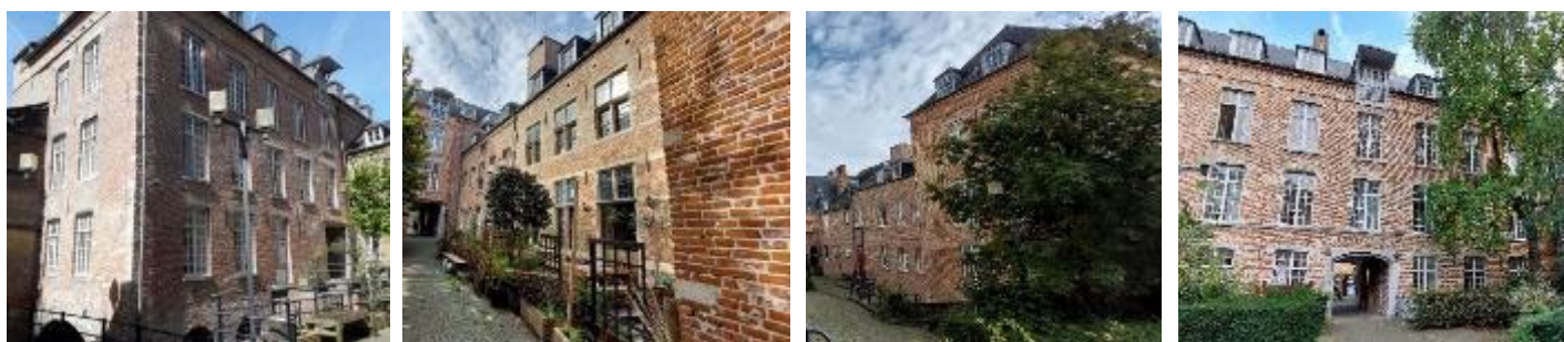
Gebouwen binnen het blok, Sint-Kristoffelstraat 34 : oostgevel (links), zuidgevel (rechts)
